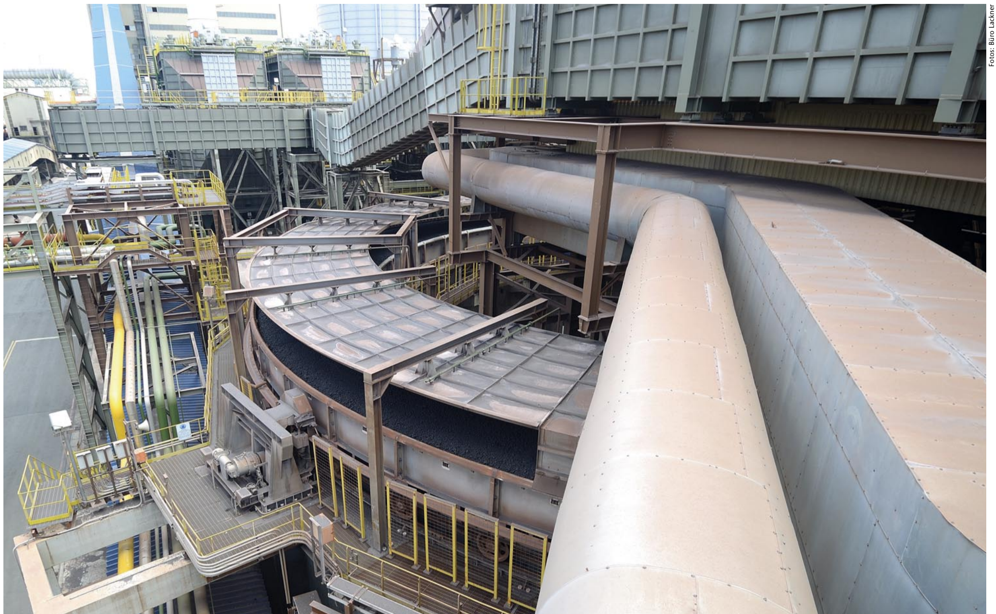
Fotos: Büro Lackner
