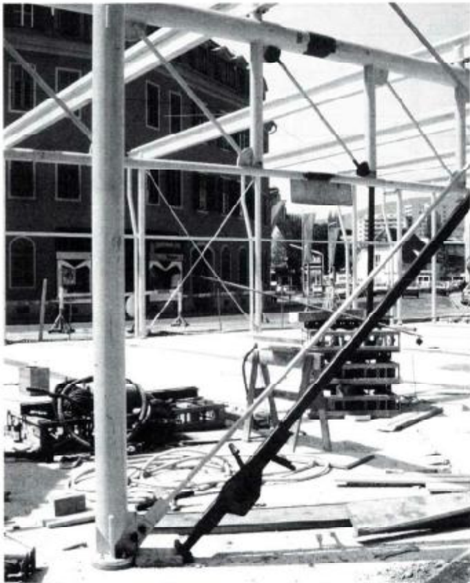
Montage des Stahlbaues. Hier ist ein Baustellenschweißstoß des Hauptbinders erkennbar.
