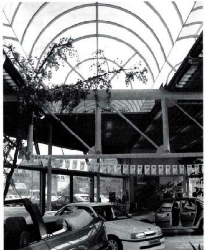
Inneransicht der fertigen Halle.
